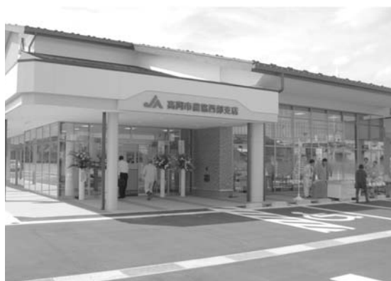
西部支店新築オープン (平成27年10月5日)
