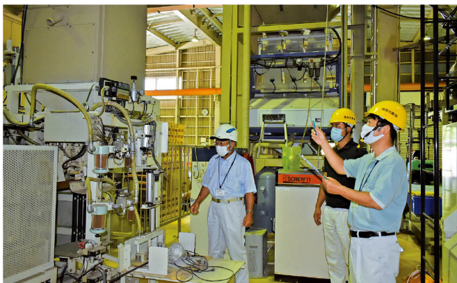
国吉カントリーエレベーターの点検を行なう職員ら
