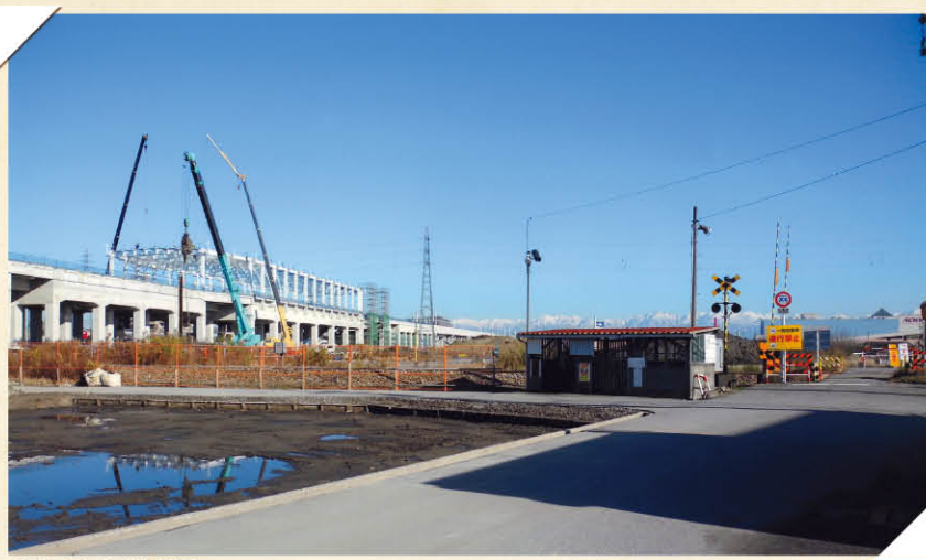
新高岡駅の駅舎建設風景
