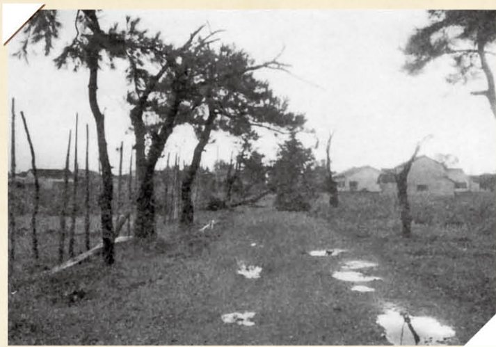
台風18号により松が倒伏した八丁道通り / 『地域で育むやすらぎ あしたのために』より
