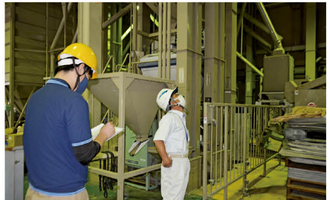
国吉カントリーエレベーター内を点検
